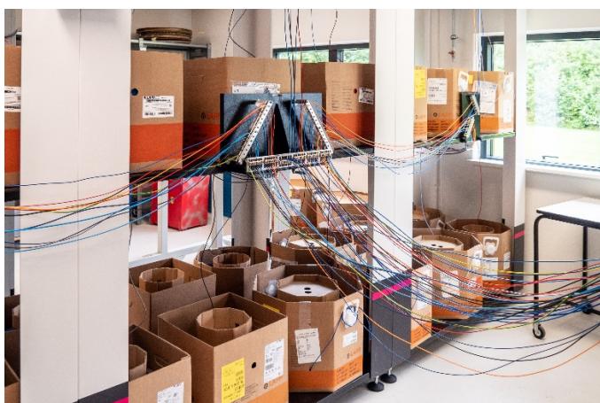
<Tricon 3> De forskellige ledningstyper indføres i Rittal Wire Terminal WT 36 direkte fra transportemballagerne.
